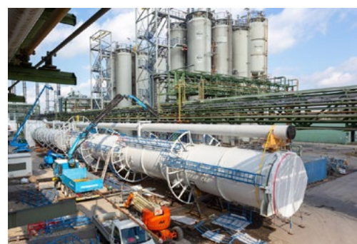
2022 年，一座新的硅烷蒸馏塔投入使用，与 1972 年的设备相比，它不仅更高，生产和节能效率也更佳。
