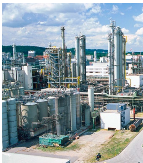
2022 年，一座新的硅烷蒸馏塔投入使用，与 1972 年的设备相比，它不仅更高，生产和节能效率也更佳。
