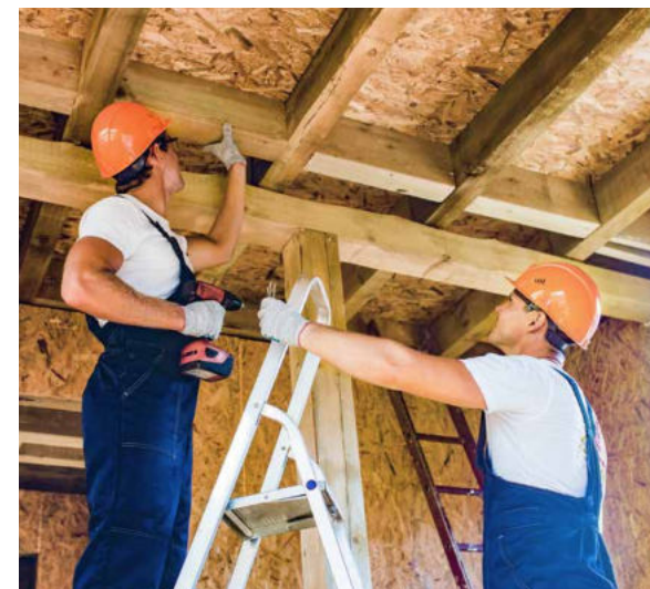
蚂蚁喜欢居住在屋顶，从而严重损坏屋梁构架和保温系统。
