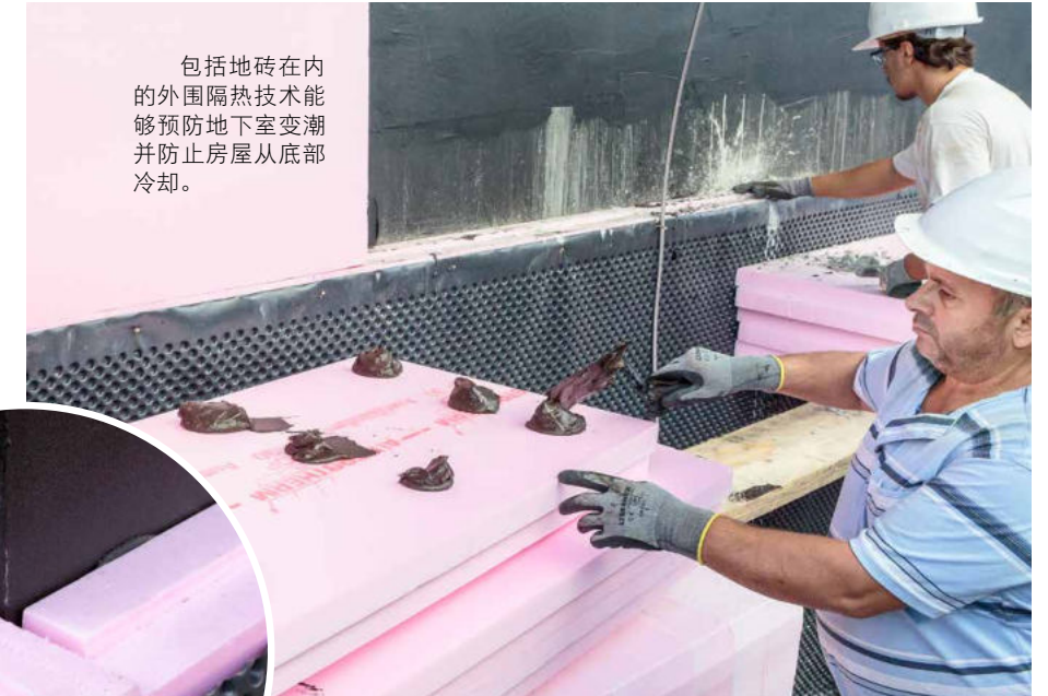
在沥青防渗层上安装由聚苯乙烯泡沫塑料或其他泡沫塑料构成的隔热板，对地下室墙壁做节能保温处理。
