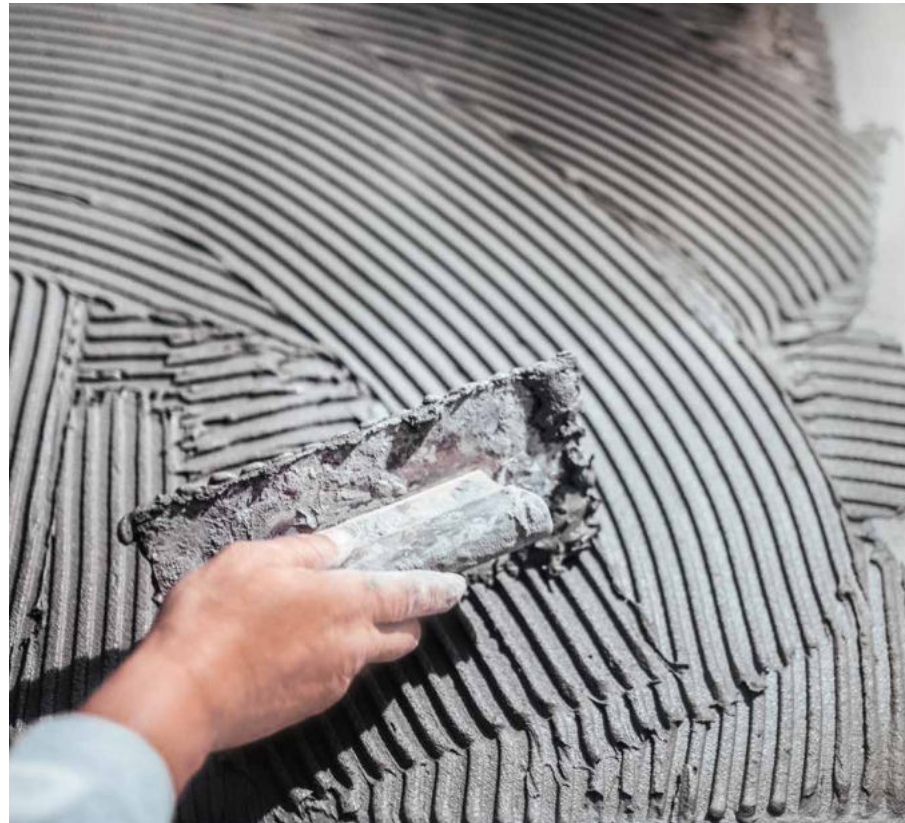
在铺设大面积瓷砖时，对墙面或地板的预处理工作必须尤为细致，基底必须平整。
