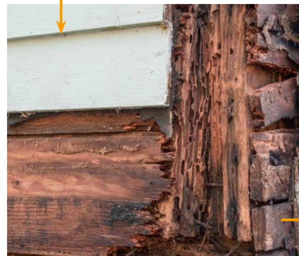
上图：蚂蚁正在侵蚀建筑外墙保温层。 下图：遭白蚁破坏的木质地基。
