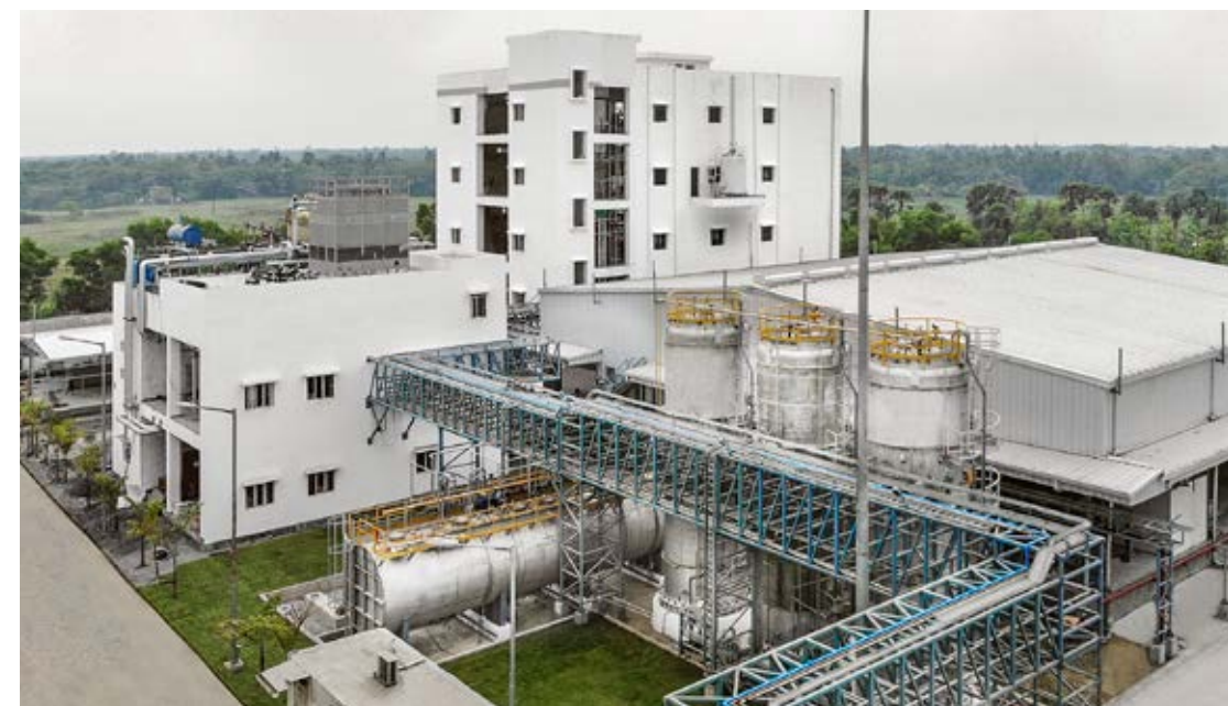
瓦克-迈储阿克化学品私营有限公司在临近加尔各答的 Amtala 生产基地新建硅氢加成反应生产线。
