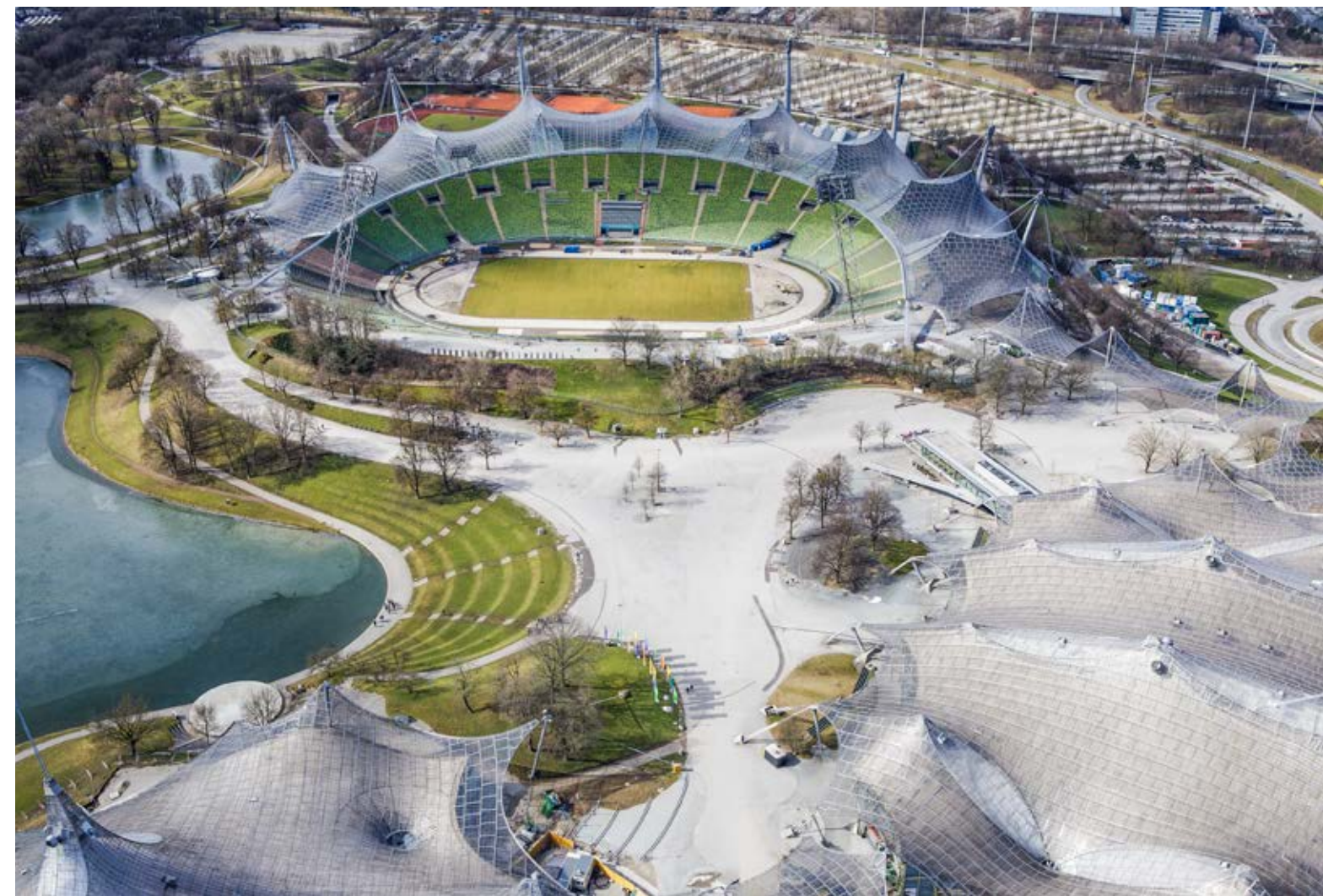
镶有有机玻璃、总面积达 72800 平方米的顶棚由交织的钢索在高达 80 米的立柱之间吊起。
