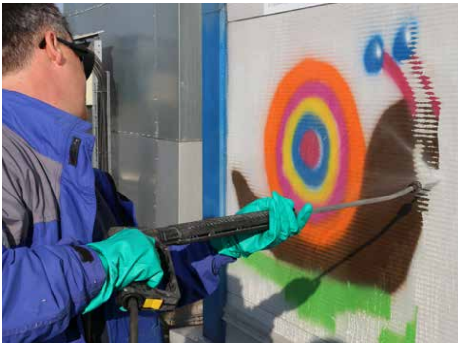
Удаление граффити. Большие граффити также можно легко удалить с помощью аппарата высокого давления с холодной водой.
