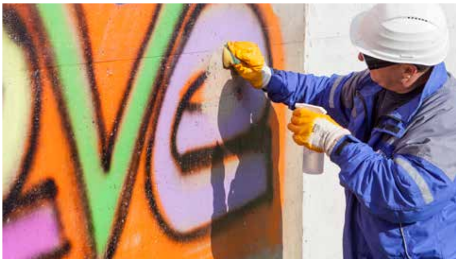
Удаление граффити: плохая адгезия граффити на поверхностях, обработанных SILRES® BS 710. Краски легко удаляются влажной тканью или губкой.
