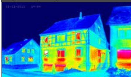
Рисунок 2: Тепловизионное изображение фасада: дом слева хорошо изолирован, тогда как дом справа — нет.
