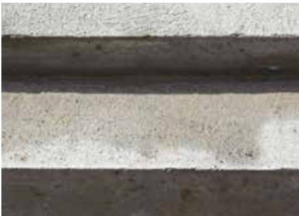
시공 후 30분 경과
