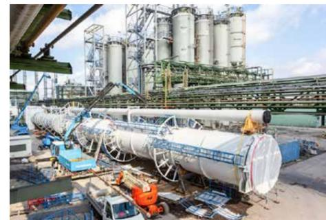
2022 wird eine neue Kolonne für die Silandestillation in Betrieb genommen. Sie ist nicht nur höher, sondern auch effektiver und energieeffizienter als die Anlage von 1972.
