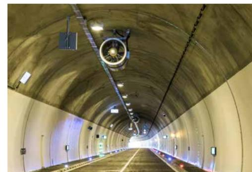
Rauchgasventilatoren in einem Straßentunnel. Die Antriebsmotoren der Ventilatoren werden im Brandfall sehr stark thermisch belastet. Eine Imprägnierung mit SILRES® H60 bietet den bestmöglichen thermischen Schutz.
