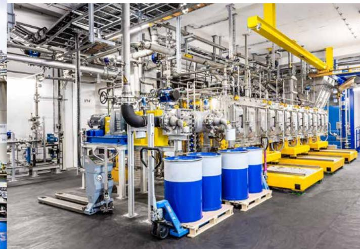
Im Betrieb für Flüssigsilikonkautschuke (großes Bild) in Burghausen entstehen ein neuer Vinylpolymer-Reaktor und eine Grundmassenanlage (kleines Bild), in deren Knetkammern die Siliconpolymere mit hochdisperser Kieselsäure weiterverarbeitet werden. Das Projekt ist Teil der Wachstumsinitiative des Geschäftsbereichs.
