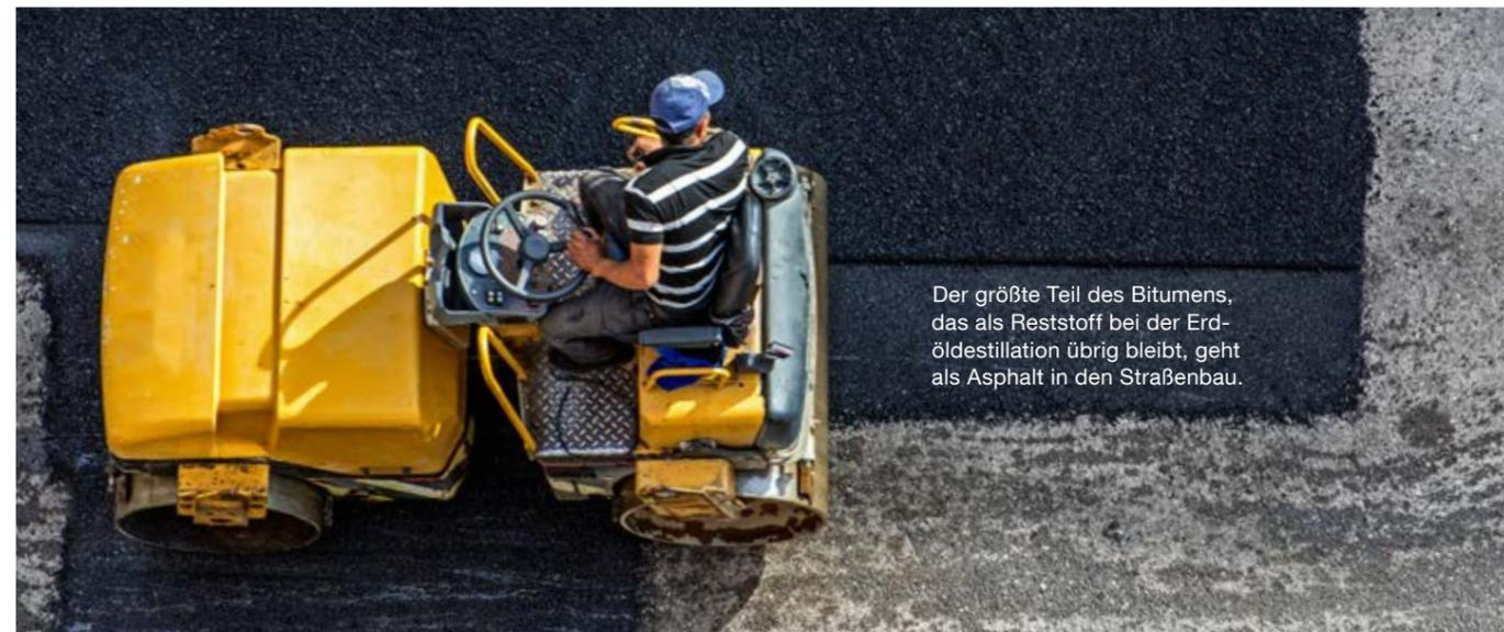
Der größte Teil des Bitumens, das als Reststoff bei der Erdöldestillation übrig bleibt, geht als Asphalt in den Straßenbau.
