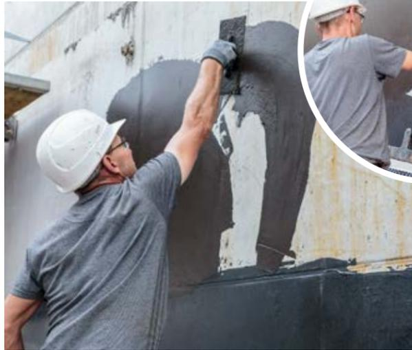
Mit polymervergütetem Bitumen dichten Handwerker Kellerwände wasserdicht ab.
