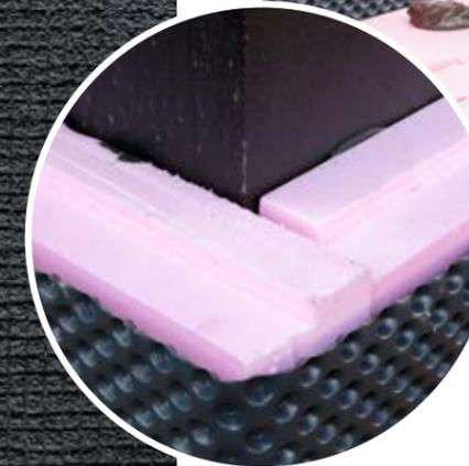
Auf die Sperrschicht aus Bitumen kommen Dämmplatten aus Styropor oder anderen geschäumten Kunststoffen, um die Kellerwand auch energetisch zu isolieren.
