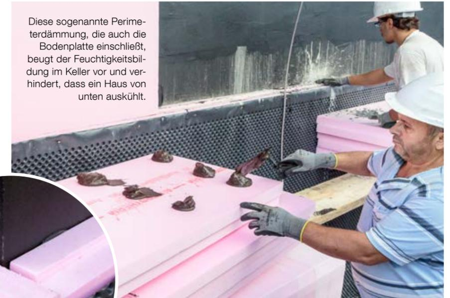
Diese sogenannte Perimeterdämmung, die auch die Bodenplatte einschließt, beugt der Feuchtigkeitsbildung im Keller vor und verhindert, dass ein Haus von unten auskühlt.
