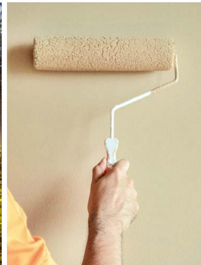
Die Polymerdispersionen von WACKER sorgen in Wandfarben dafür, dass Pigmente, Füllstoffe und Additive zusammenhalten und die Farbe optimal und dauerhaft auf der Wand bleibt.
