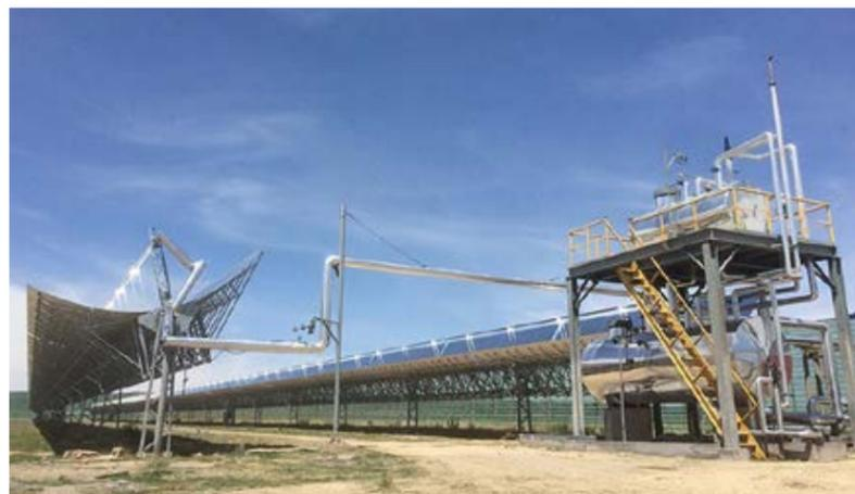
CSP-basierte Solarthermiekraftwerke – CSP steht für concentrated solar power – bündeln mittels verspiegelter Parabolinnenkollektoren das einfallende Sonnenlicht und erhitzen auf diese Weise das in einer Vakuumröhre fließende Wärmeträgeröl.
