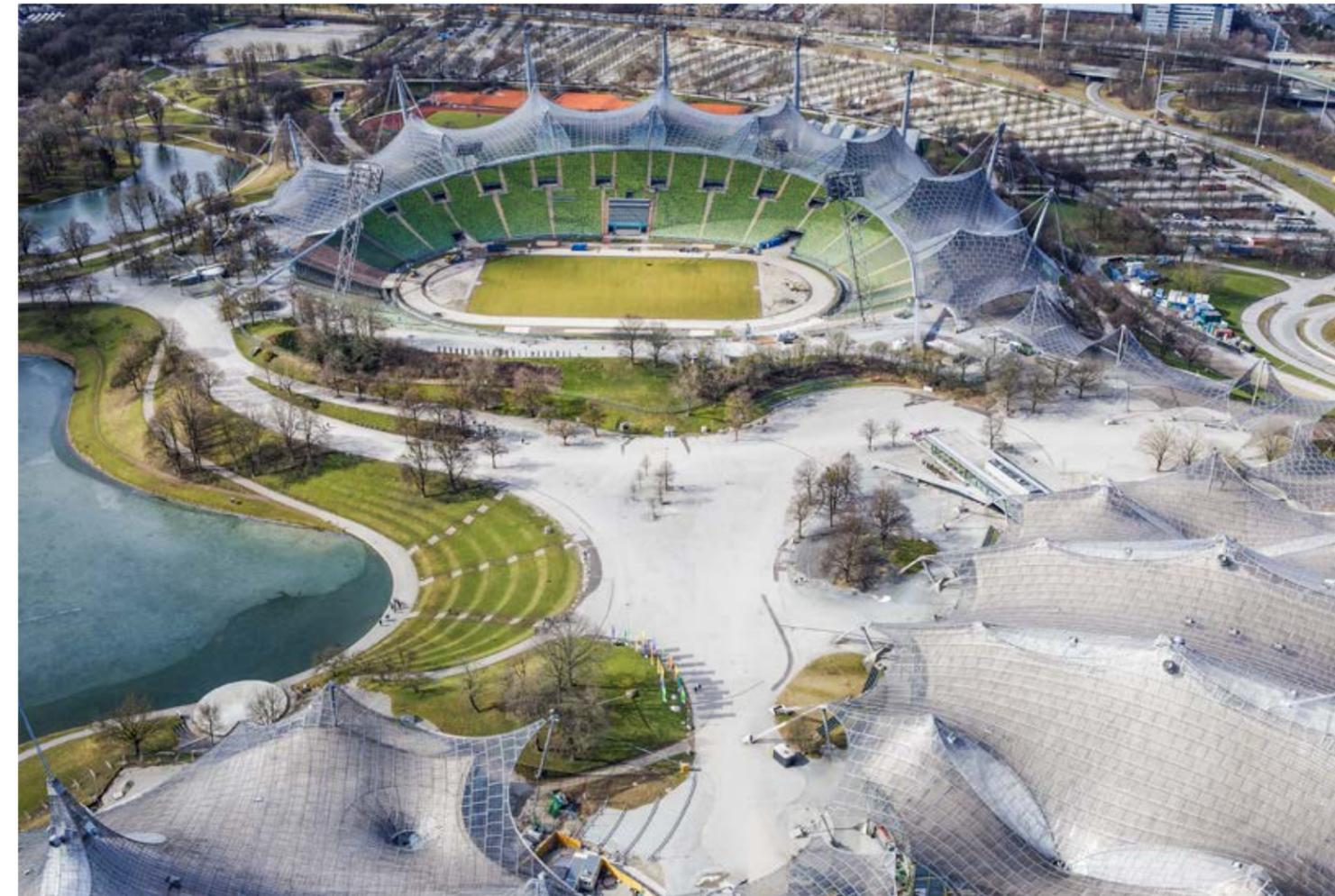
Die 72.800 Quadratmeter große Dachlandschaft besteht aus Seilnetzen, die an bis zu 80 Meter hohen Pylonen aufgehängt und mit Acrylglasplatten verkleidet sind.
