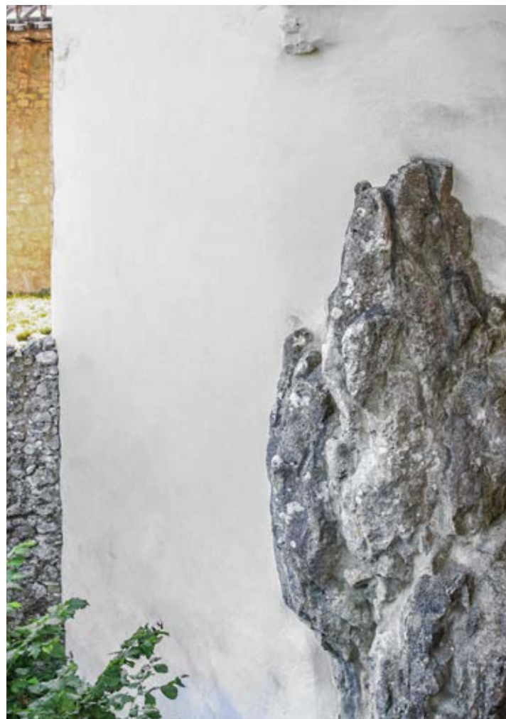
Der Felsen am Treppenturm der Burg Prunn trotz jeglichen Witterungseinflüssen.
