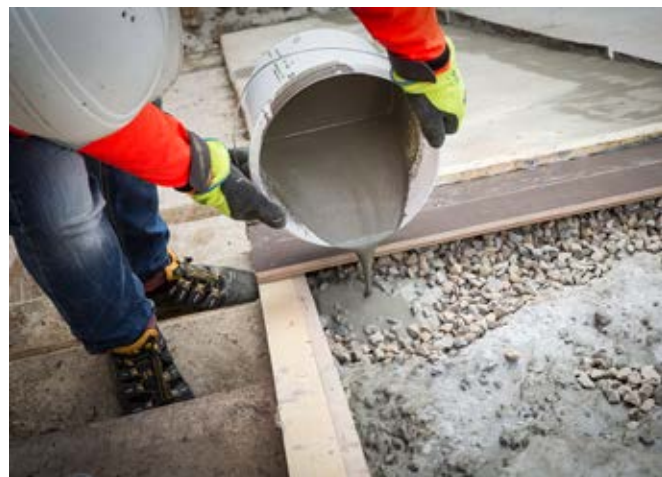
Großer Vorteil der Self-Filling-Concrete-Technologie ist, dass damit schnell und kostengünstig große Flächen verfüllt werden können.
