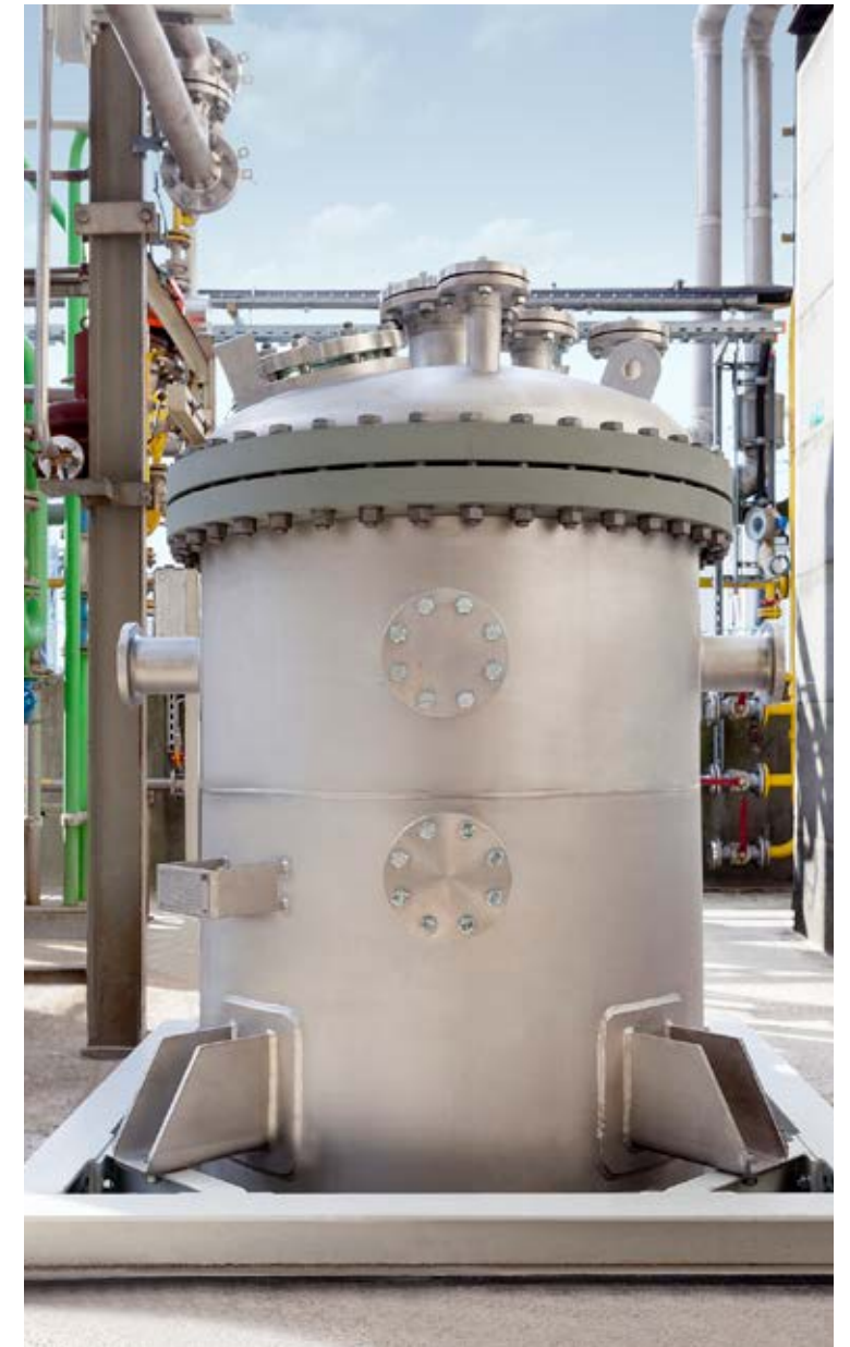
Neuer IPA-Reaktor als Teil der Keten-Verbundproduktion in Burghausen: In verschiedenen Schritten entstehen hier aus Essigsäure Keten, Isopropenylacetat und Acetylaceton.
