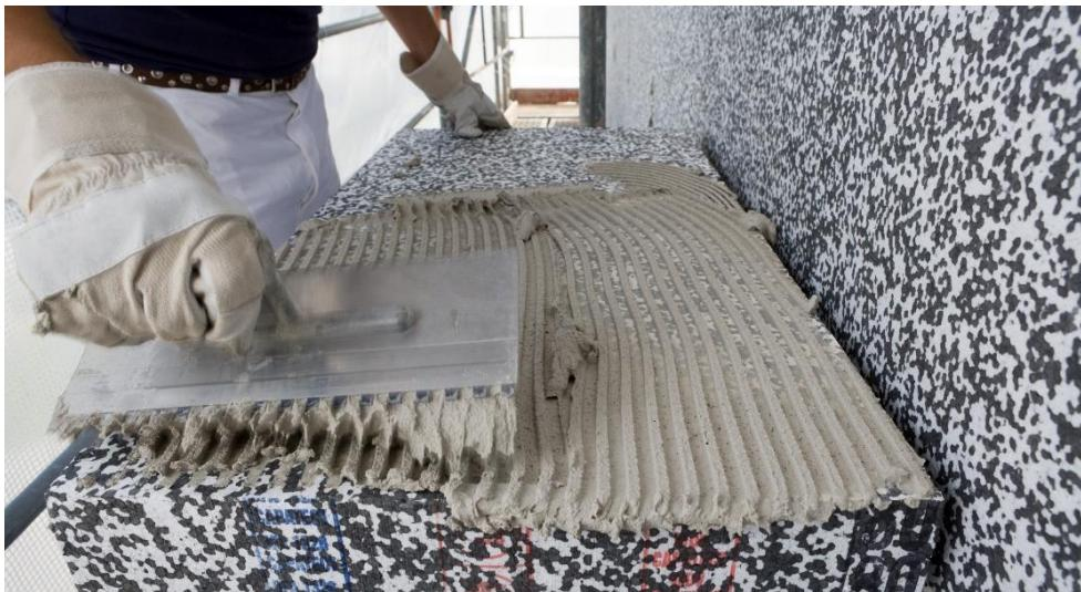
瓦克的聚合物基料 VINNAPAS®威耐实®4449 E 专为外墙外保温系统（ETICS）用粘结砂浆的配方开发。该产品在涂层系统内具有极强的粘结力，卓越平衡因温度变化或其它因素引起的张力。瓦克集团将在纽伦堡的 ECS 2023 上首次展出该新品。（照片：瓦克）
