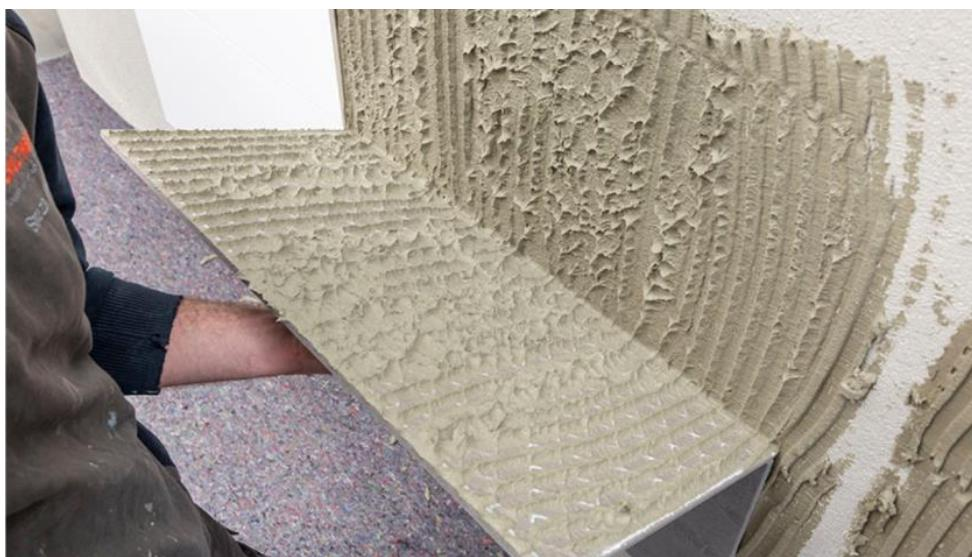
聚合物基料 VINNAPAS®威耐实®4419 E 和 VINNAPAS®威耐实®8819 E 改善瓷砖胶粘剂的润湿性能，延长更正时间。瓦克将于 ECS 2023 上展出该新品（照片：瓦克）
