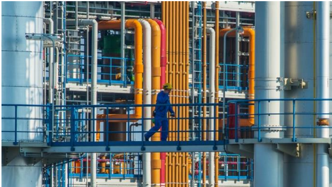
Teilanlage der Polysiliciumproduktion in Nünchritz (Deutschland)
