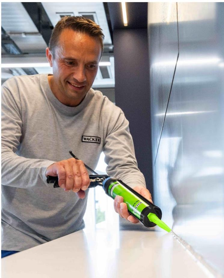
ELASTOSIL® eco 7770 P dringt dank eines speziellen Siliconweichmachers nicht in die Poren von Marmor, Granit oder Sandstein ein. Der Naturstein bleibt dadurch makellos. (Foto: WACKER)
