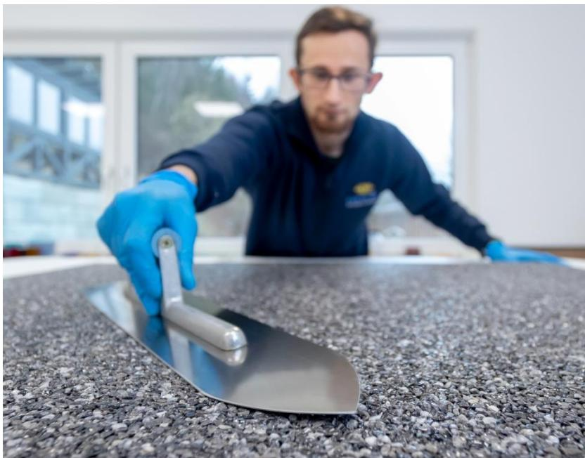
Mit dem Siliconharz SILRES® BS 6920 können Harzsysteme für die Fixierung von Bodenbelägen aus Steingranulat hergestellt werden. WACKER stellt das Produkt auf der European Coatings Show 2023 in Nürnberg vor. (Photo: WACKER)
