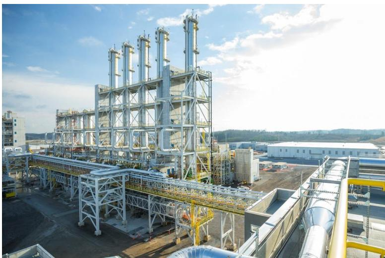
Destillationskolonnen zur Herstellung von Trichlorsilan am Standort Charleston im US-Bundesstaat Tennessee. WACKER produziert dort seit 2015 hochreines Polysilicium, seit 2019 auch pyrogene Kiesel säure der Marke HDK®. (Foto: WACKER)
