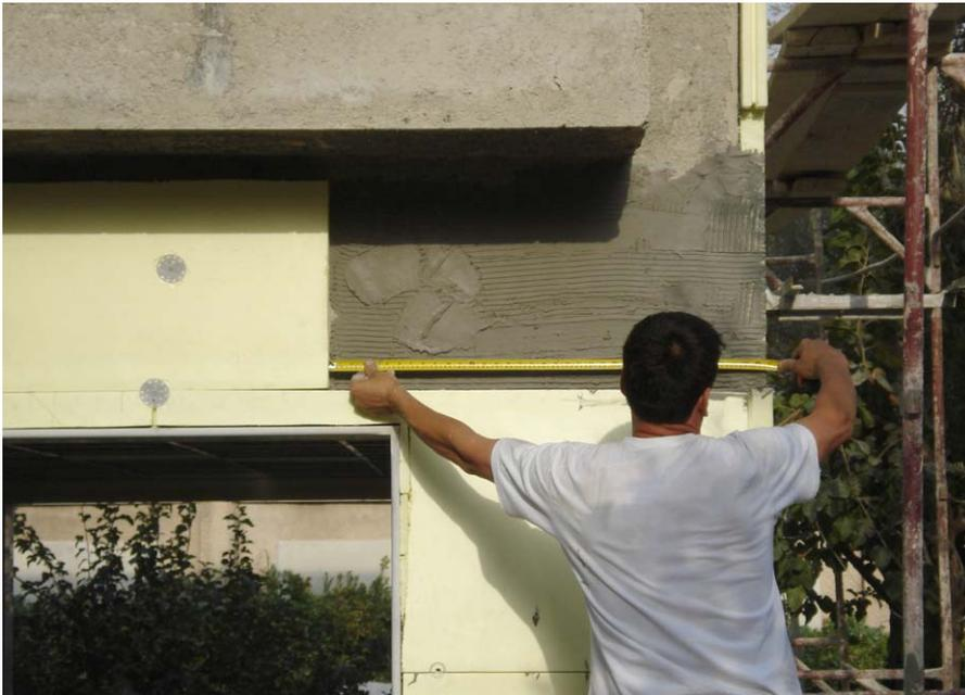
Bauarbeiter versehen in Syrien ein Haus mit einem Wärmedämmverbundsystem. In einem Pilotprojekt wurde mithilfe von WACKER-Experten die optimale Formulierung für den Klebemörtel erarbeitet, der ideal auf die klimatischen Bedingungen in Damaskus abgestimmt ist (Foto: Wacker Chemie AG).
