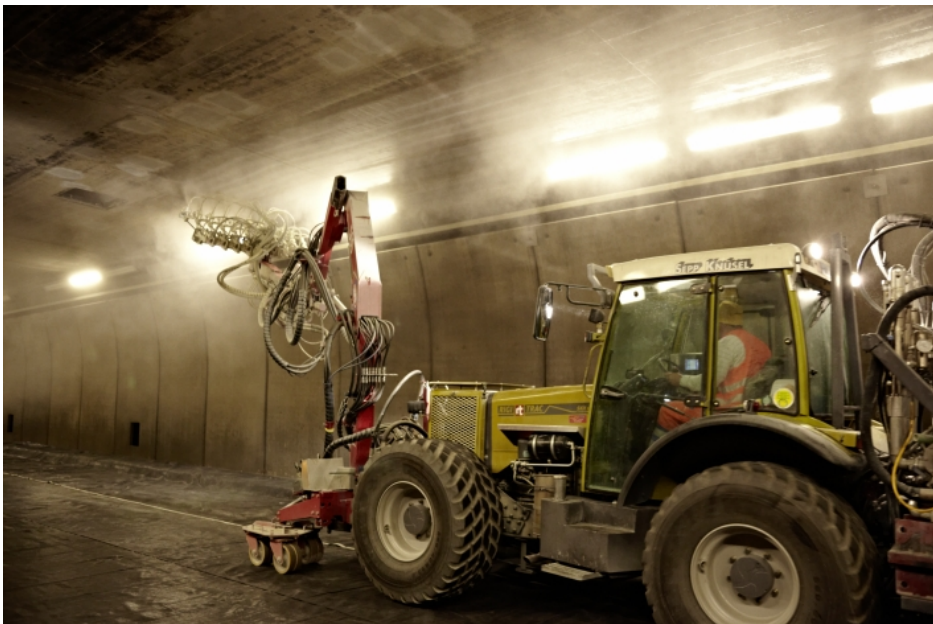
Wettlauf gegen die Uhr: Ende September wurde die Decke des Gotthard-Tunnels mit SILRES® BS Creme C von WACKER imprägniert. Die Behandlung schützt den Tunnel dauerhaft gegen Feuchtigkeit und Salz. (Foto: Wacker Chemie AG)
