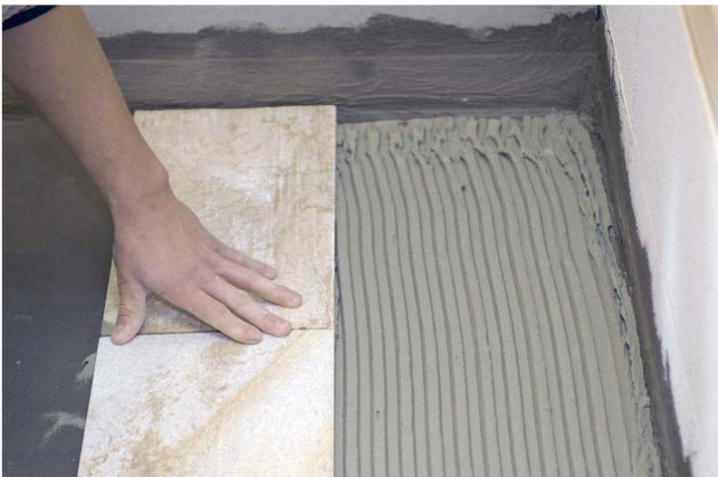
Unter Fliesenkleber aufgetragen, schützen mit VINNAPAS® modifizierte Dichtungsschlämmen Wände und Böden in Feuchträumen wie Bädern oder Kellern vor Feuchtigkeit (Foto: Wacker Chemie AG).
