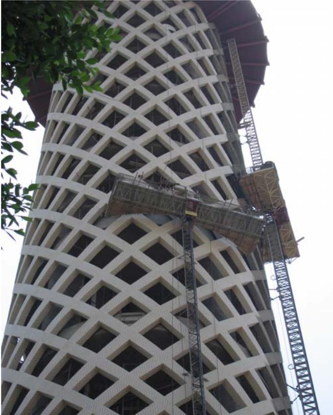
Die aufwändige Sanierung des Kairo Towers stellte hohe Qualitätsansprüche an die Zusatzstoffe für Putz, Mörtel, Kleber und Fugenfüller. Mithilfe der Experten von WACKER wurden spezielle Formulierungen mit VINNAPAS®-Dispersionspulvern entwickelt, um den Fernsehturm für die Herausforderungen durch Hitze, Trockenheit oder Wind zu rüsten (Foto: EKY).
