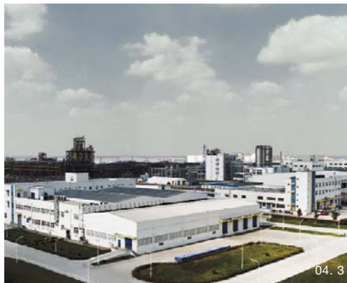
04. 3 Der neue WACKER-Standort in Zhangjiagang.
