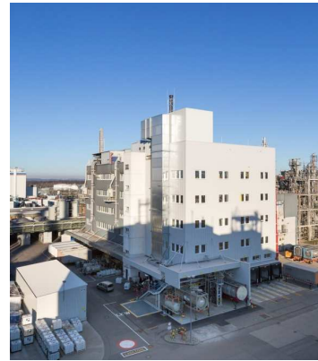
Siliconanlage in Burghausen (Deutschland)
