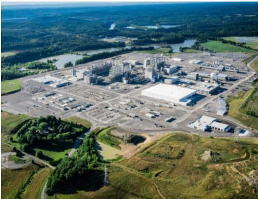
Standort Charleston (Tennessee, USA)
