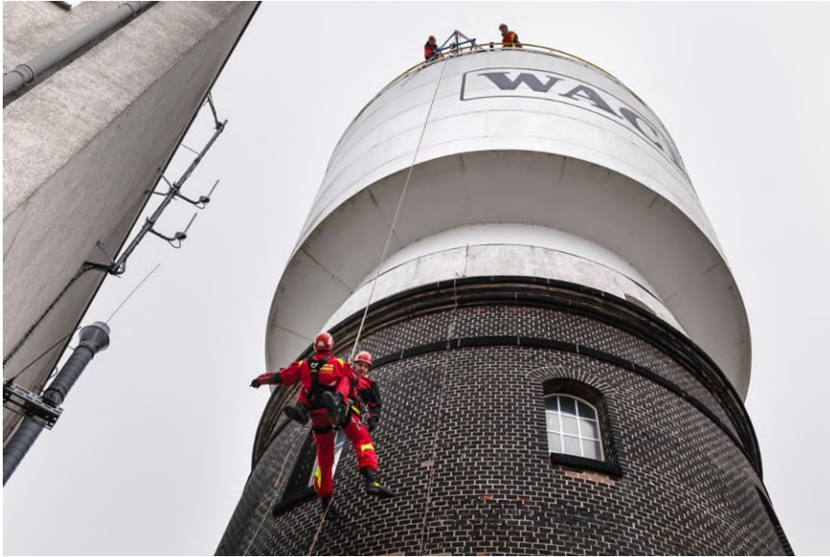
Abseilen vom 26 Meter hohen Wasserturm
